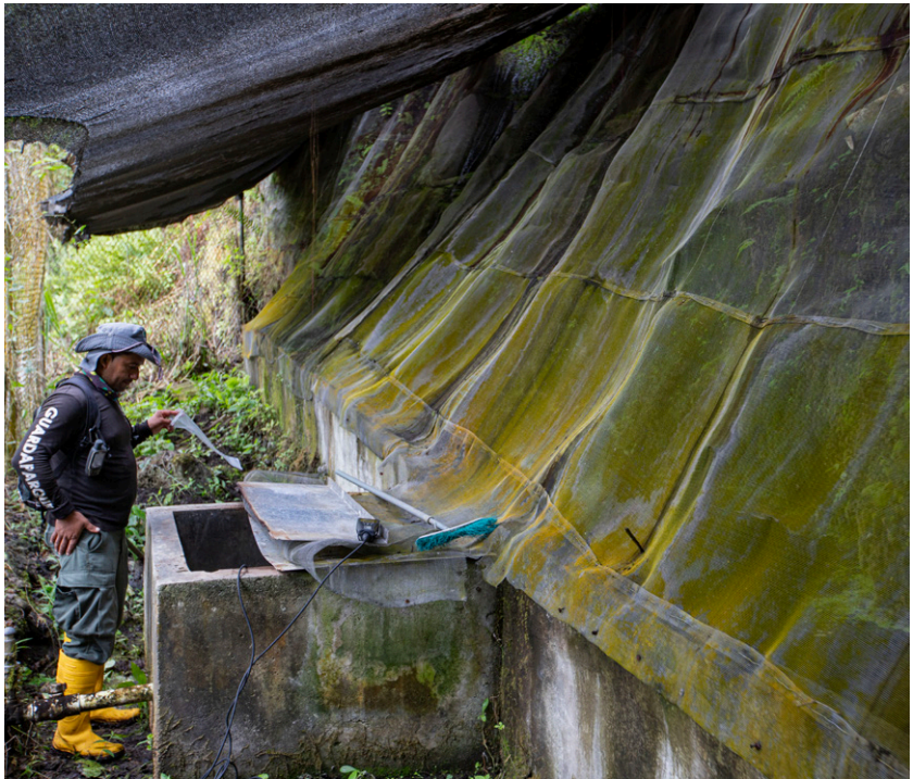
Figura B. Vertiente (arriba) y captación (abajo) de agua dulce en Asilo de la Paz, Floreana. Figure B. Freshwater spring (above) and capture (below) at Asilo de la Paz, Floreana.
