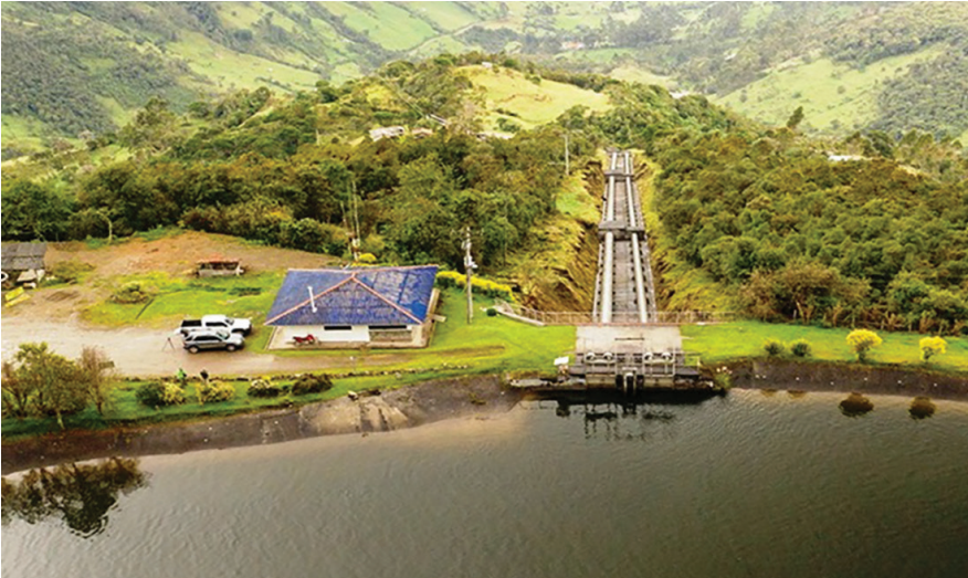
Figura 11.4 Proyectos de hidroelectricidad que utilizan agua que se genera en los páramos: reservorio de Turi en la central hidroeléctrica Saucay-Saymirín (Azuay). Fotografía: Celec, Ecuador
