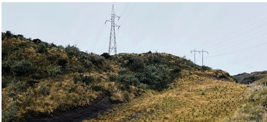
Figura 11.10 Torres y líneas de alta tensión del Sistema Nacional Interconectado que pasan por el páramo de a) Cayambe Coca, con derecho de vía del Oleoducto de Crudos Pesados (OCP) que cruza el páramo de Papallacta. Fotografía: Patricio Mena-Vásconez
