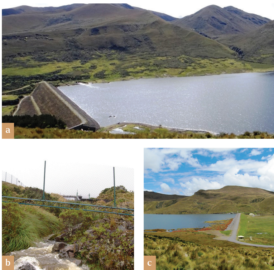
Figura 11.2. Elementos de la infraestructura construida en los páramos de áreas protegidas del Ecuador y sus zonas de influencia, a) Parque Nacional Llanganates: embalse para hidroelectricidad Pisayambo. b) Zona de influencia Parque Nacional Antisana: regulación para agua potable. c) Parque Nacional Antisana: reservorio para agua potable en La Mica. Fotografías: Celec (a), Daniela Rosero-López (a) y Patricio Mena-Vásconez (c)
