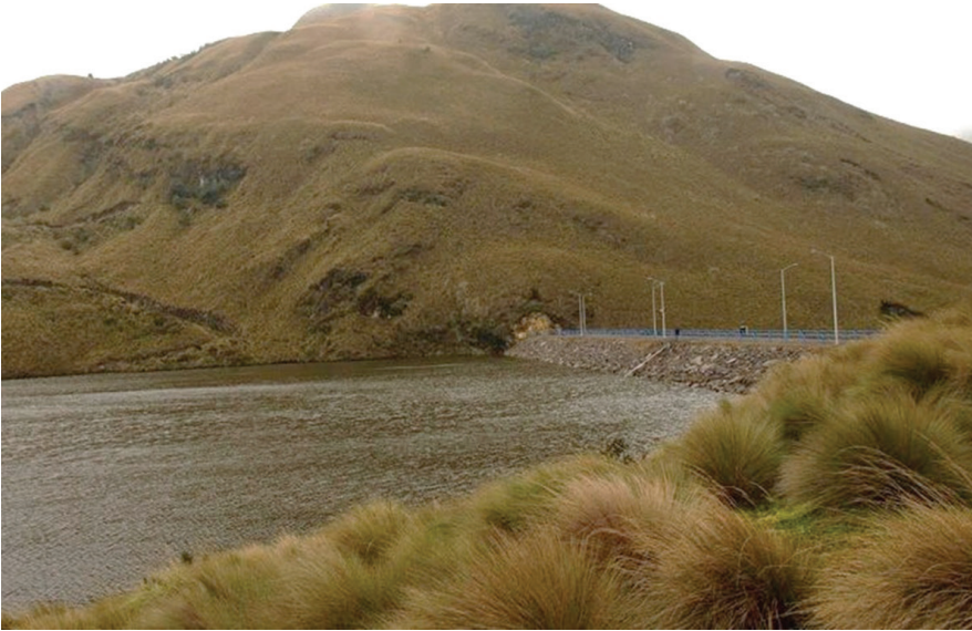
Figura 11.8 Embalse de agua construido en depresiones orográficas naturales en donde previamente no existían laguna y que actualmente presenta una represa de limitada altura (Represa Salve Faccha; PN Cayambe Coca). Fotografía: EPMAPS, Ecuador
