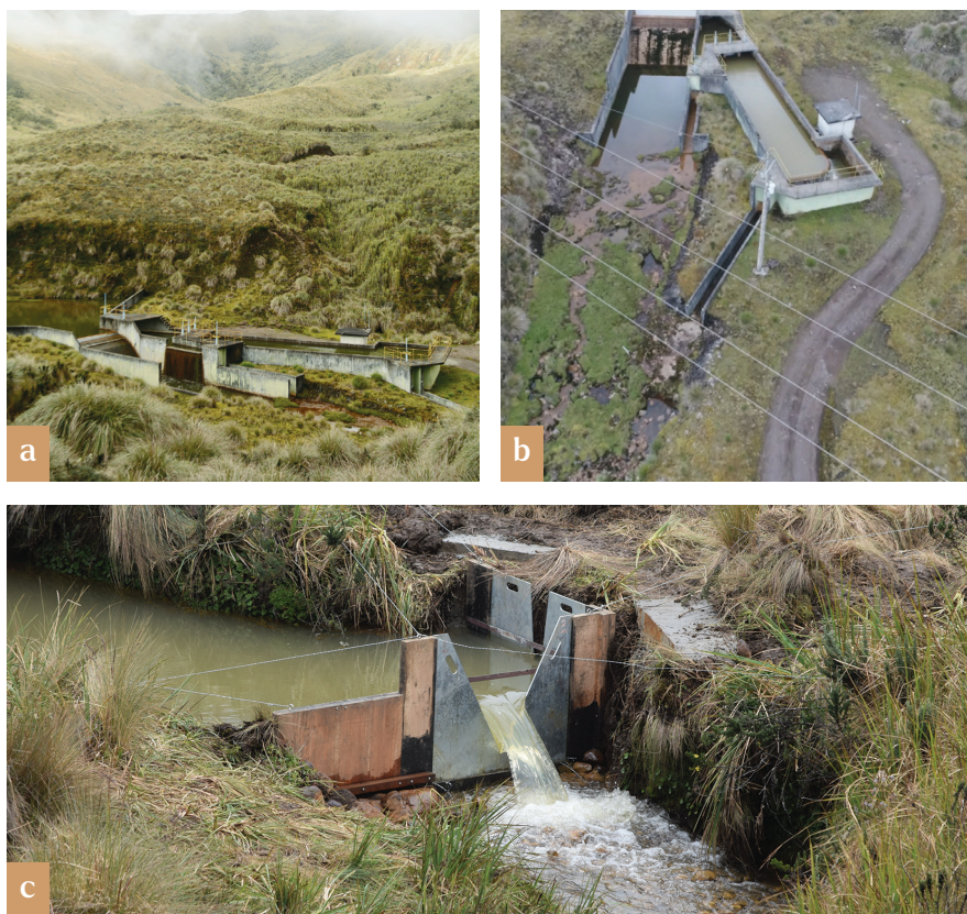
Figura 11.9 Río Chalpi Norte, Napo: a) Captación de agua en río construida en los páramos de Papallacta. b y c) Desviación experimental para la manipulación de caudales mediante vertederos complementarios para el análisis de la respuesta del sistema entero a los diferentes caudales ecológicos. Fotografías: Robert Hofstede (a) y Daniela Rosero-López (b y c)
