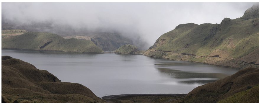
Figura 11.7 Reservorio de agua construido sobre lagunas naturales y diseñado para la regulación y almacenamiento de agua potable en el Sistema Papallacta (laguna de Mogotes). Fotografía: Daniela Rosero-López
