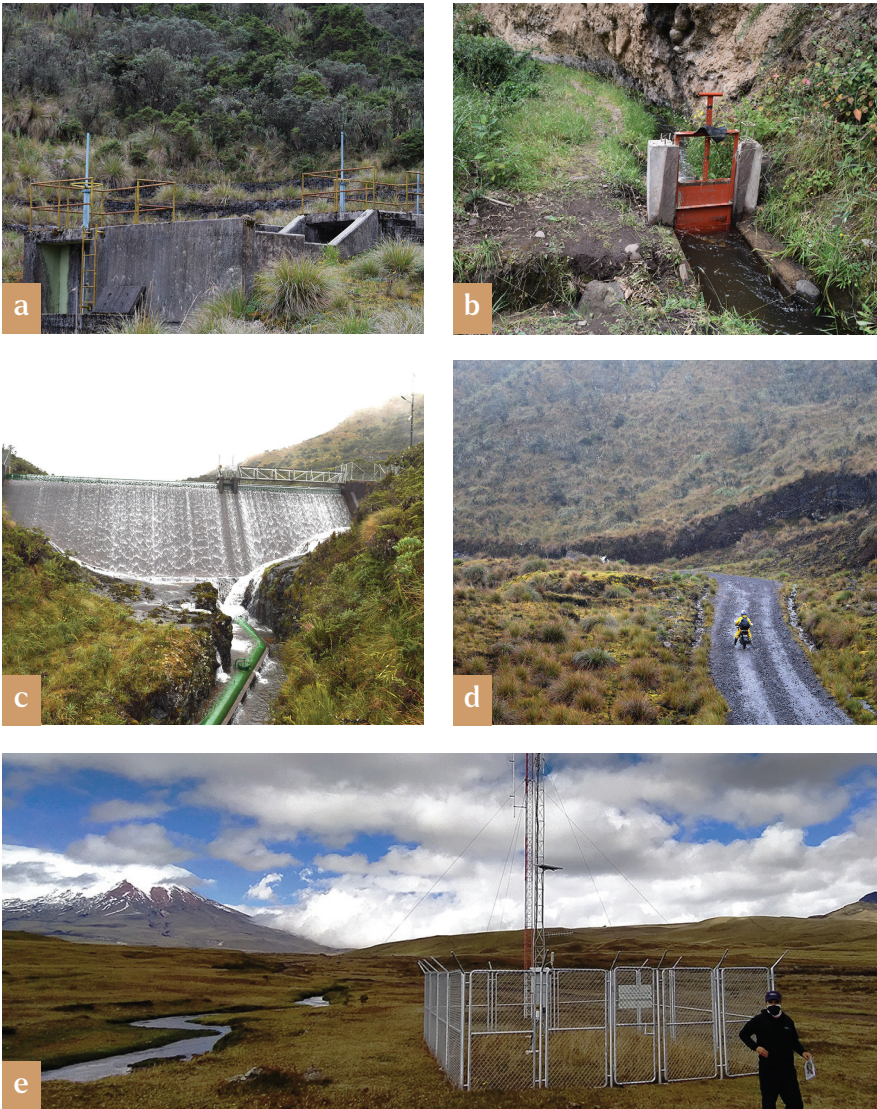
Figura 11.1 Algunos elementos de infraestructura construida en los páramos del Ecuador: a) Captación de agua potable. b) Canal de riego. c) Hidroelectricidad. d) Comunicación. e) Medición meteorológica. Fotografías: Daniela Rosero-López (a-d) y Robert Hofstede (e)
