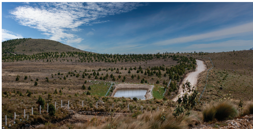
Figura 10.2 Páramo de Quimsacocha en la zona de concesión minera de oro donde se ve una piscina de tratamiento de desechos y forestación con pinos. Fotografía: Gustavo Morejón
